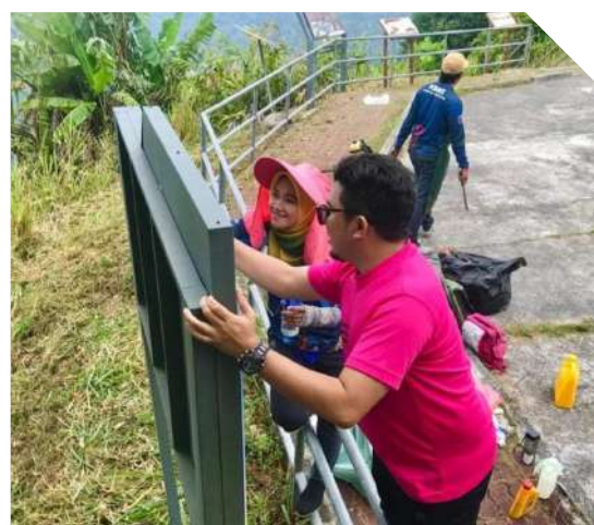
Kerja-Kerja Penyelenggaraan & Pembersihan Geotapak
